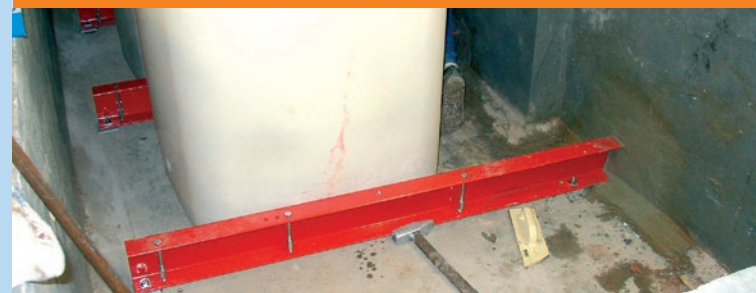
Sicherung von Behältern gegen Aufschwimmen
