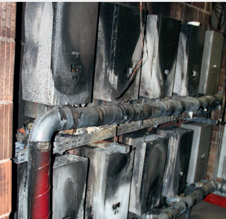
Bild 15 | Technikraum einer PV-Anlage nach einem Brand
