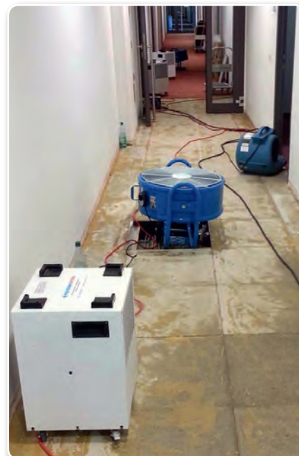
Bild 4 | Umfangreiche Trocknungsarbeiten auf mehreren Etagen waren über Wochen notwendig
