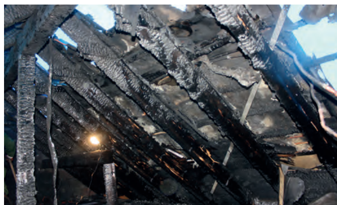
Bild 3 | Darstellung der Brandzehrungen im Spitzboden im Bereich der Solarkollektoren
