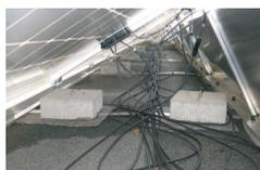
**Leitungsverlegung:** Die Leitungen sind an der Modulstange zu befestigen, so dass sie nicht auf der Dachfläche aufliegen. Bei Metaldächern hohe Gefahr des Lichtbogens.
