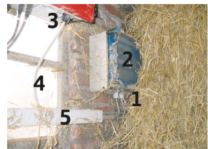
Errichtungsfehler – Brandgefahr:
